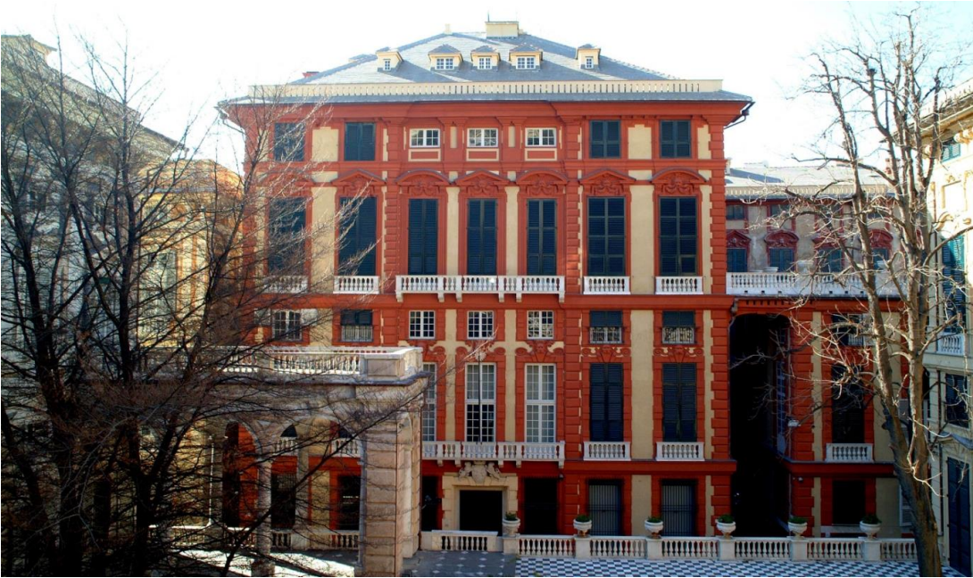
El Palacio Rosso, en Vía Garibaldi. (Fuente: Ayuntamiento de Génova)
